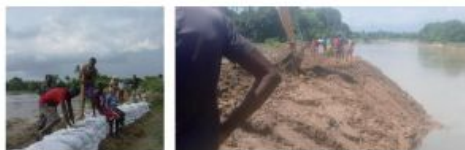
(홍수피해를 복구 중인 재배마을 사진)
